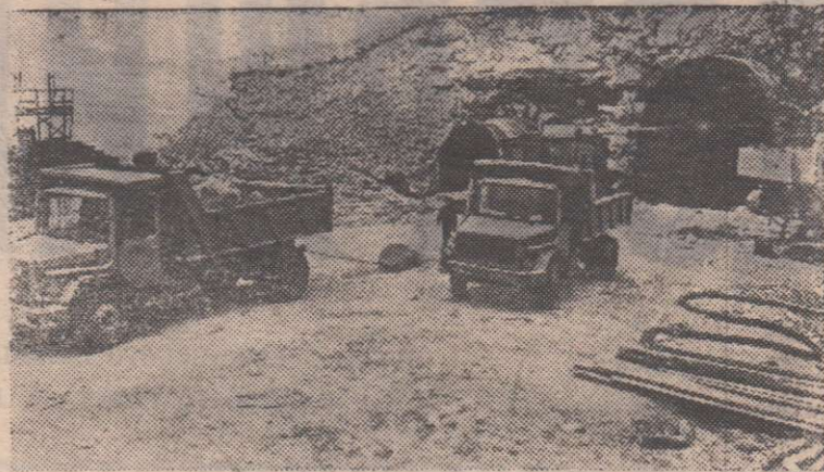
Бурятская АССР. На западном участке Байкало-Амурской магистрали в отрогах Байкальского хребта начата проходка основного ствола семикилометрового Байкальского тоннеля — одного из самых крупных на трассе.
